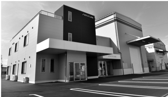
写真1 事務棟及び工場の外観
