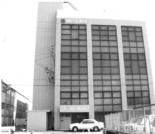
写真1 本社及び本社工場
